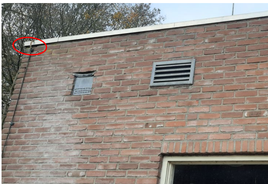
Figuur 3.2: Invliegopening tussen kier daklijst met buitengevel
