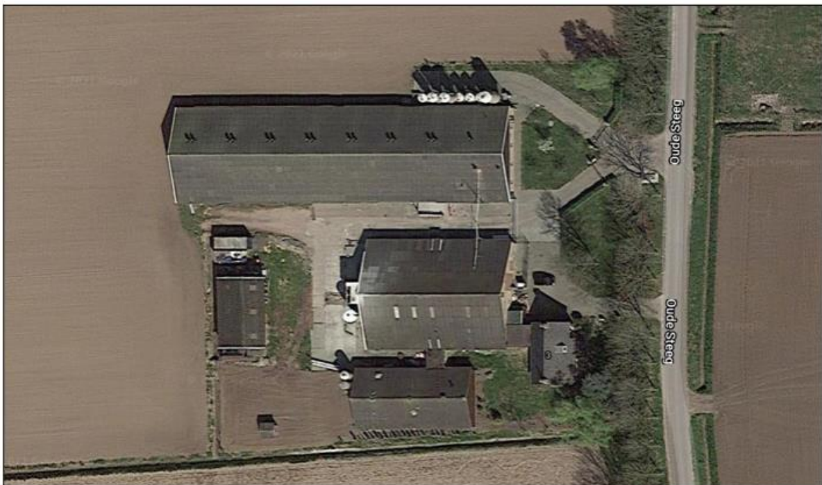
Afbeelding 2.1 Luchtfoto huidige situatie plangebied (Bron: Google maps)
